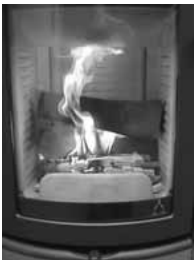
Ill.3 : Chiusura presa dell'aria primaria
