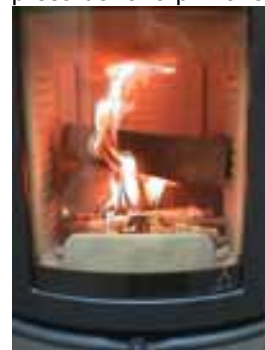
III. 3 : Chiusura presa dell'aria primaria
