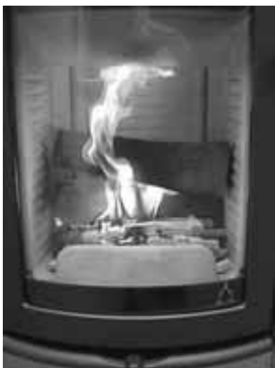
Ill. 3: Chiudere la presa dell'aria primaria
