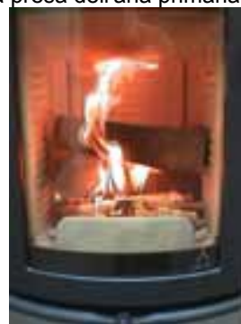
III. 3 : Chiusura presa dell'aria primaria
