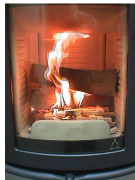
Fig. 4: Primärluftschieber schließen
