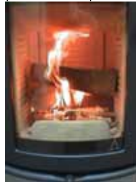
III. 3 : Chiusura presa dell'aria primaria
